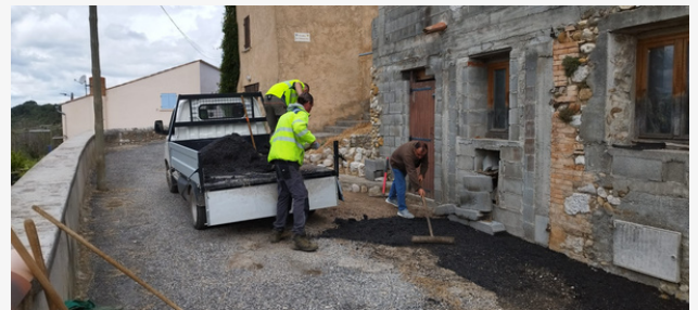
Réfection de la voirie.
